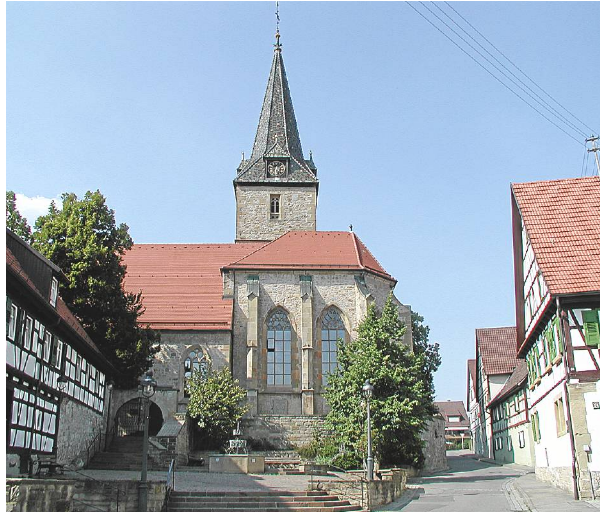
Die evangelische Martinskirche ist das prägende Gebäude im alten Kornwestheimer Ortskern.
